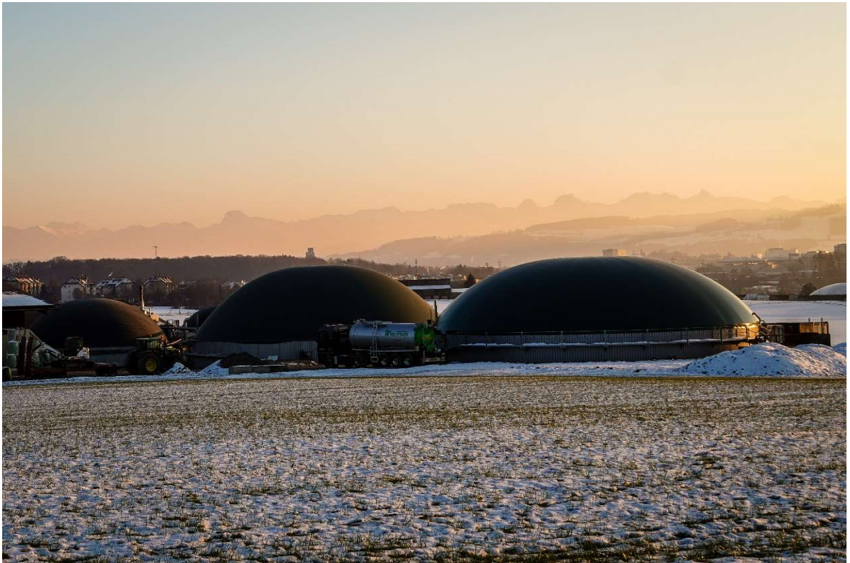
Biogasanlage in der Region Bern
