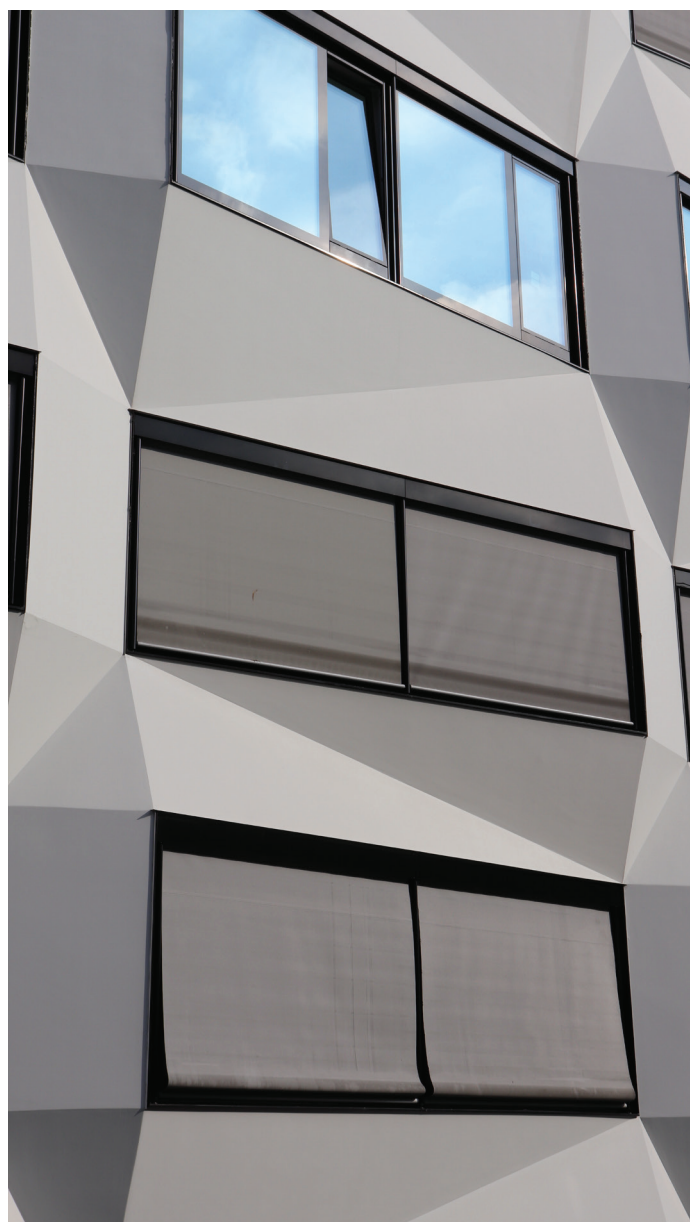
Art und Benutzung des Sonnenschutzes beeinflussen den Wärmeeintrag ins Innere von Gebäuden – in der Folge steigt oder sinkt der Heizwärmebedarf. Foto: B. Vogel
