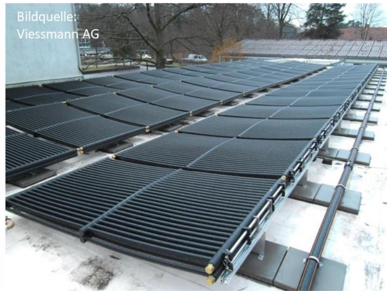
Abbildung 3: Die beiden unterschiedlichen Kollektor-Konzepte, die in den Systemen eingesetzt werden: Links der selektiv beschichtete Edelstahl-Kissenabsorber von Energie Solaire, rechts die doppellagig angeordneten Kunststoffrohre von Viessmann.
