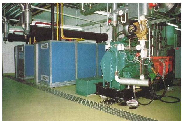
Gasmotor-Wärmepumpenanlage
