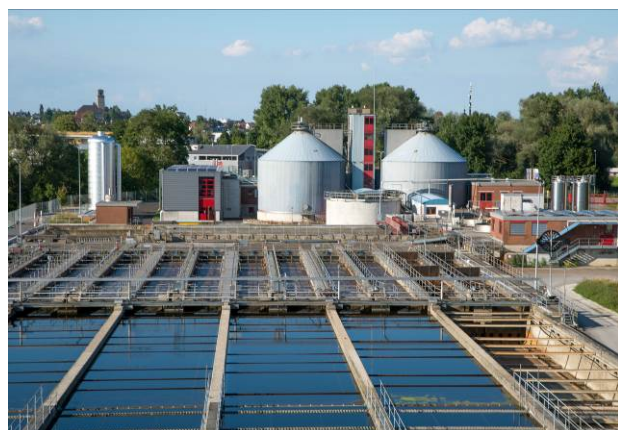
Kläranlage Morgental (SG)
