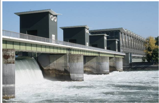
Flusskraftwerk Birsfelden (BL)
