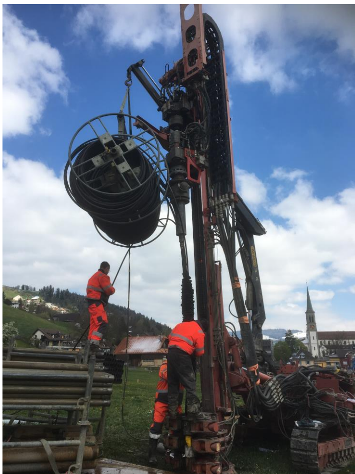
Abbildung 2: Einbau eines Erdwärmesonden-Strumpfs (Quelle: CSD Ingenieure AG)
