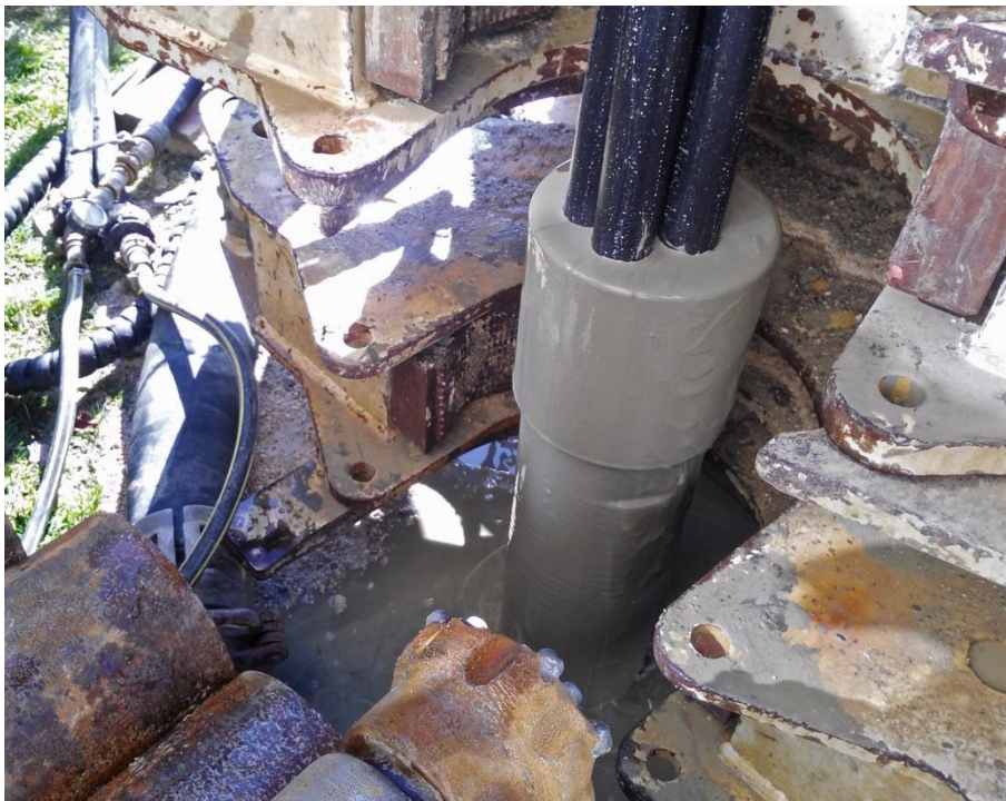
Abb. 5 Am Bohrlochkopf austretende Suspension.
