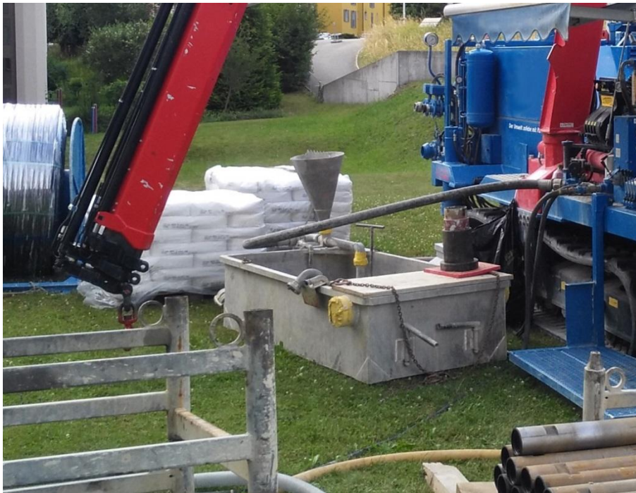
Abb. 4 Wanne zum Anmischen der Suspension
