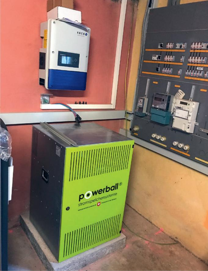
Eine AC-Ankoppelung zeichnet sich durch die hohe Flexibilität aus: Das Speichersystem kann unabhängig von der Photovoltaikanlage installiert werden. Bildquelle: Tritec
