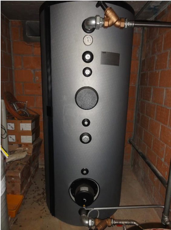
Abbildung 11: Ansicht Trinkwarmwasserspeicher
