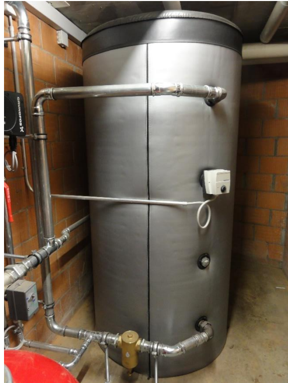
Abbildung 12: Ansicht Heizungsspeicher 3
