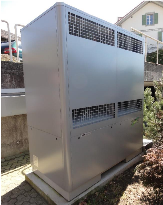
Abbildung 5: Frontansicht Luft-Wasser-Wärmepumpe
