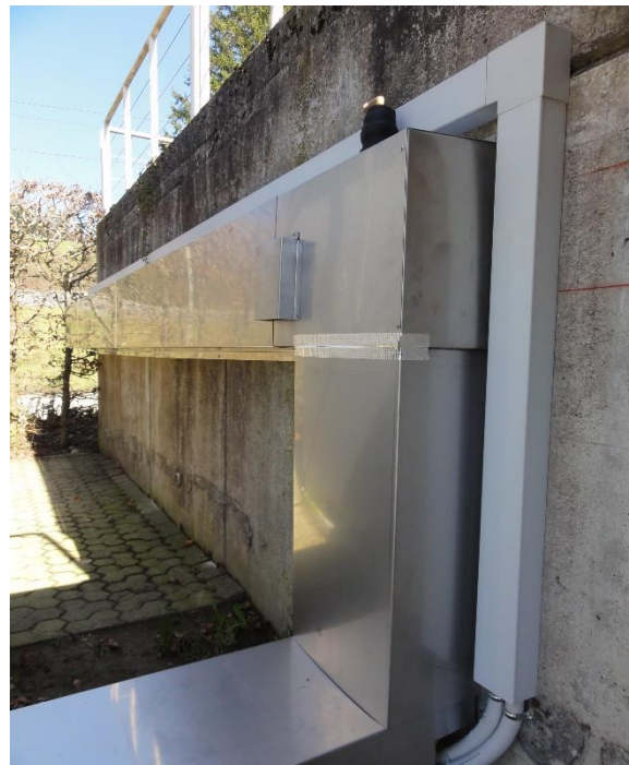
Abbildung 8: verkleidete Hauptleitungen Heizung und Stromleitung
