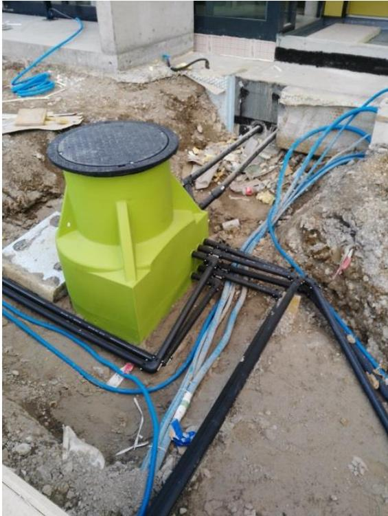
Abbildung 12 Verteilerschacht aussen
