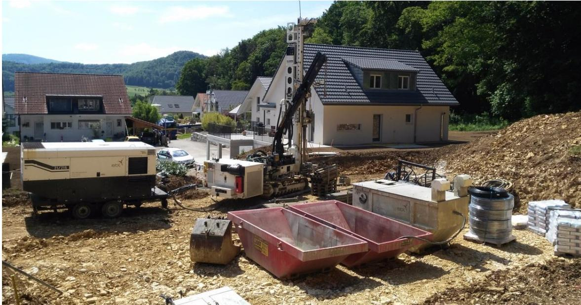
Abbildung 2 Erdsondenbohrung mit Bohranlage, Kompressor, Schlammmulden, Hinterfüllungsmaterial und Sonden
