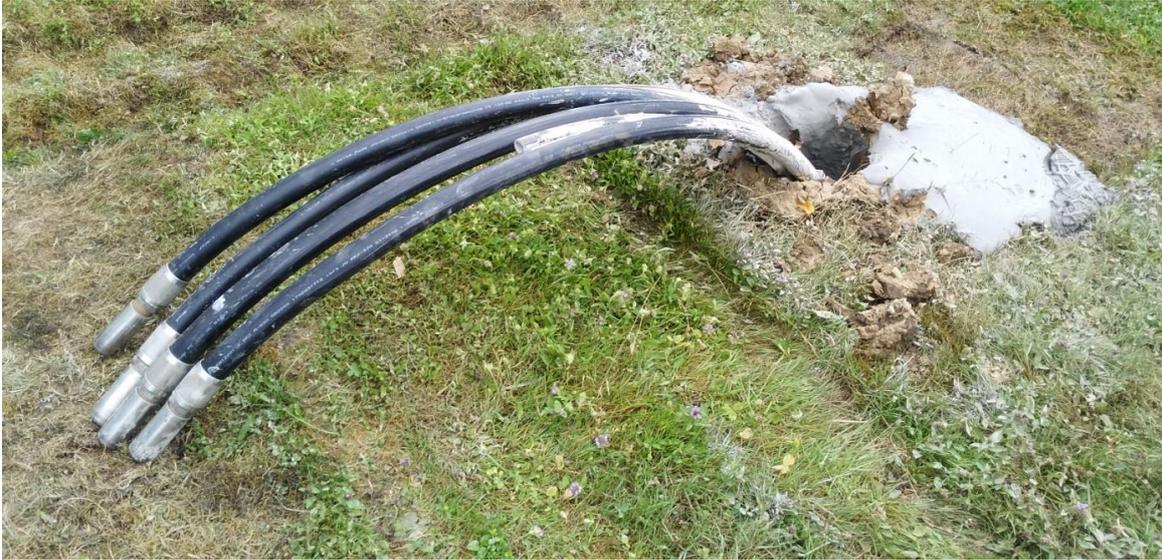
Abbildung 9 Sonden bleiben nach Einbringen der Hinterfüllung druckdicht verschlossen. die Hinterfüllung in der Bohrung ist etwas nachgesackt und muss später wieder aufgefüllt werden.
