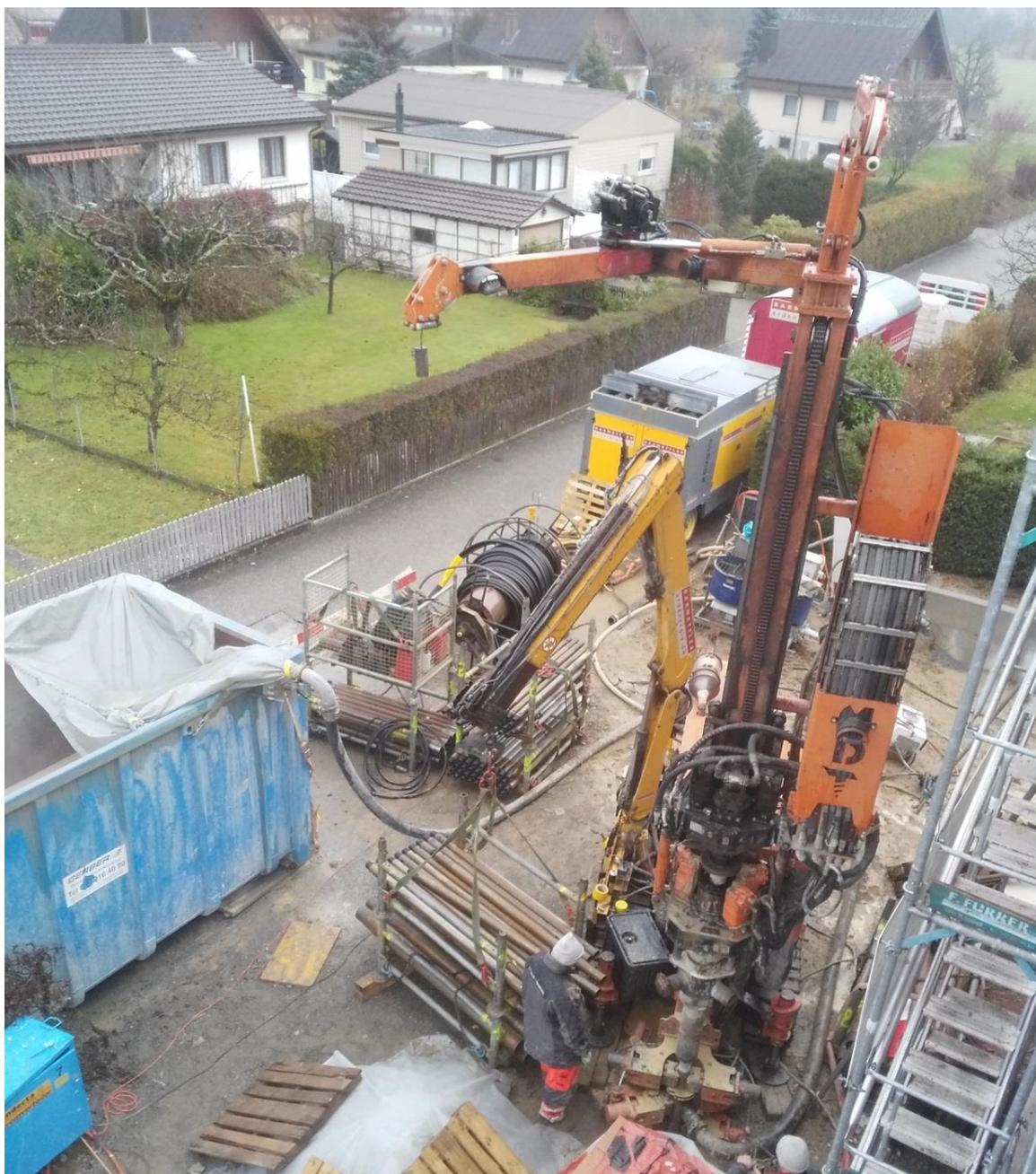
Abbildung 5 Bohrgerät mit Ausrüstung entlang der Strasse (Schlammmulde, Schläuche, Kompressor, Mannschaftswagen, Lieferwagen)
