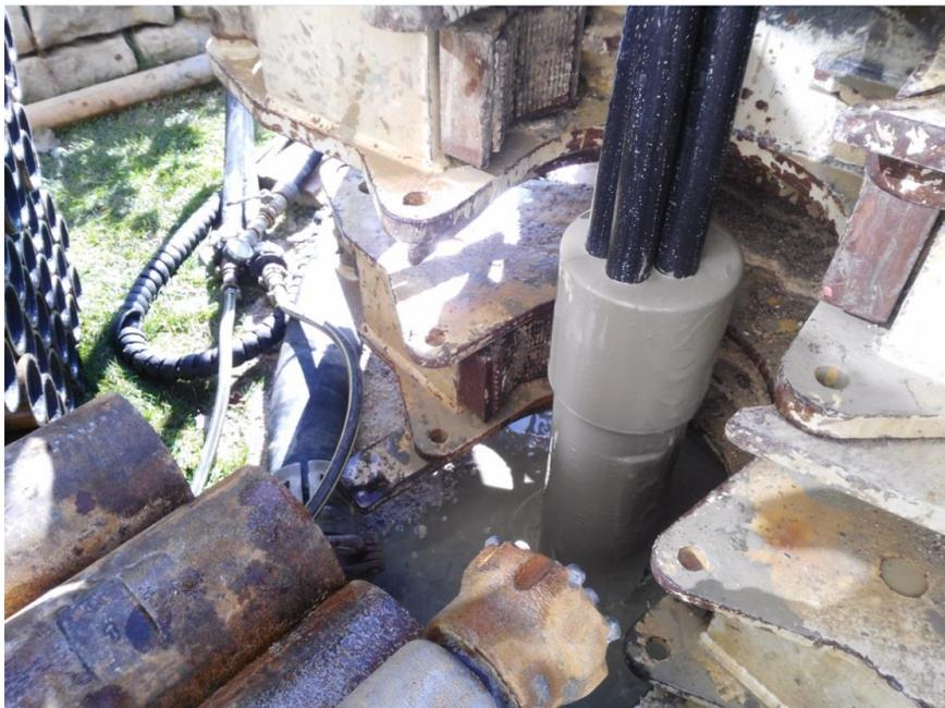
Abbildung 8 Vollständige Hinterfüllung der Bohrung. Die Hinterfüllung tritt zu Tage.
