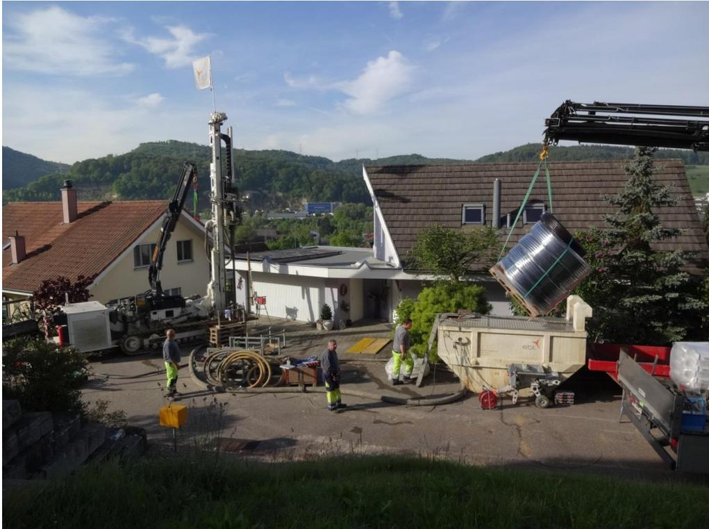
Abbildung 4 Bohreinrichtung mit Bohrgerät, Schlammmulde, Mischpumpe, Sonden-schläuche und LKW
