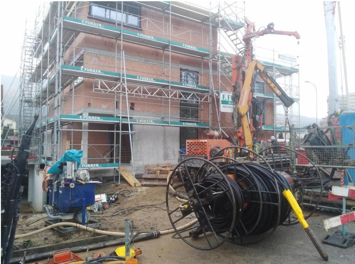
Abbildung 6 Erdwärmesondenrohre mit Hinterfüllungsschlauch auf der Haspel. Am Sondenfuss wird ein Schwergewicht angebracht.
