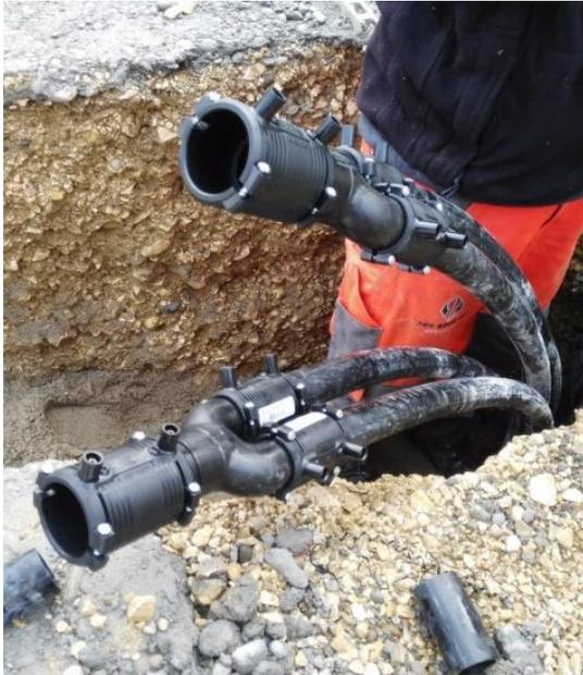
Abbildung 13 Die beiden Vor- und Rückläufe der Erdwärmesonde werden mittels Hosenstücken zusammengefasst und mittels einer PE50 Leitung an den Verteiler (-schacht) geführt
