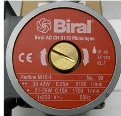
Abbildung 2: Typenschild Pumpe, Quelle: Biral Redline M10-1
