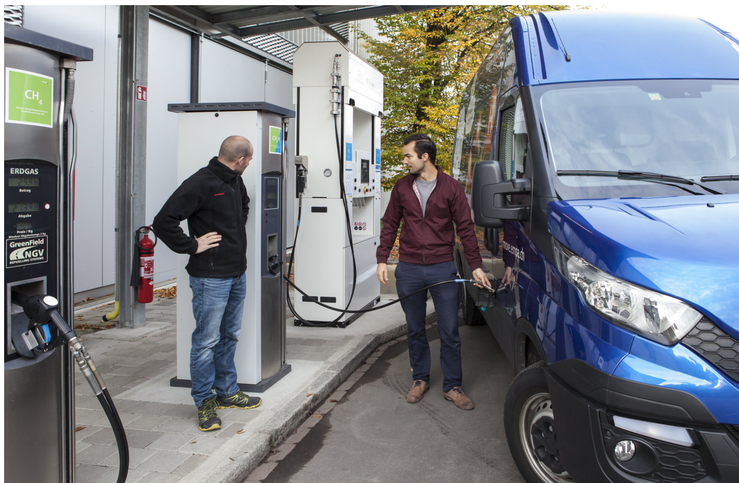
Die drei Zapfsäulen des «move»-Projekts an der Empa stellen unterschiedliche Treibstoffe bereit: Methan (vorne), ein Methan-Wasserstoff-Gemisch (Mitte) und Wasserstoff (hinten). Foto: Empa
