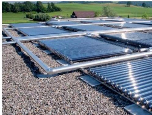
*Abbildung 15: Vakuumröhrenkollektoren bei der Kerzenfabrik Fischer AG in Root zur Warmhaltung des Paraffins*
