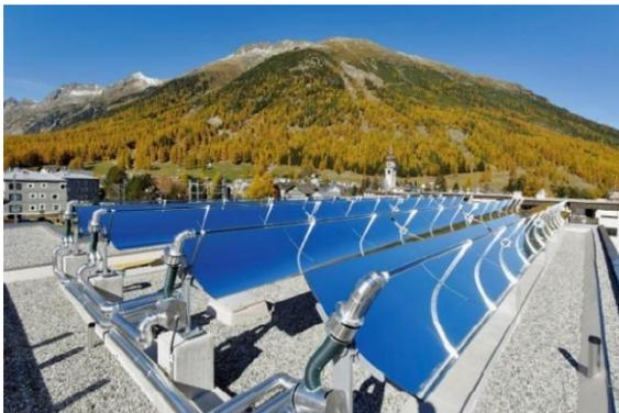
*Abbildung 14: Parabolrinnenkollektoren auf dem Dach der Lalaria Engadinaisa SA in Bever zur Erzeugung von Prozesswärme für die Milchverarbeitung*
