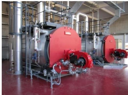
Abbildung 20: Erdgas- und Biogasbrenner Brauerei Locher. Quelle Weisshaupt
