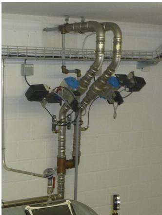
Foto 5: Zeitgesteuerte Absperrventile für Werk 1 und Werk 2
