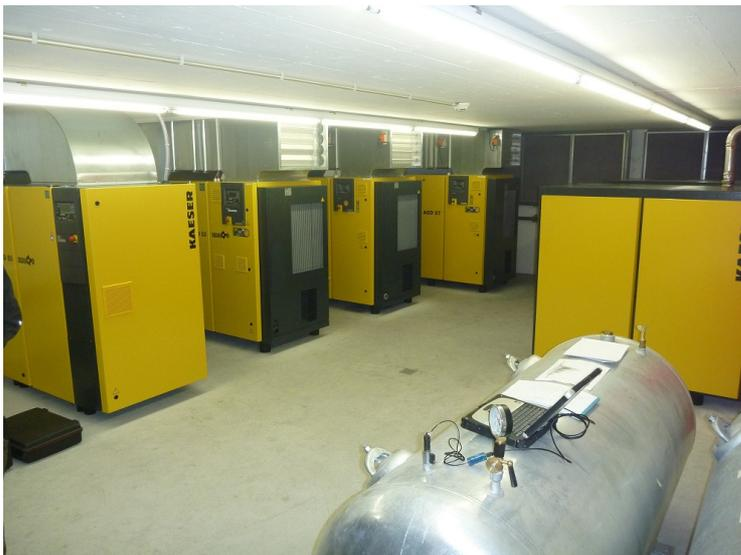
Foto 6: Kompressorraum. Links die 4 Kompressoren, rechts die beiden Kältetrockner und Speicher
