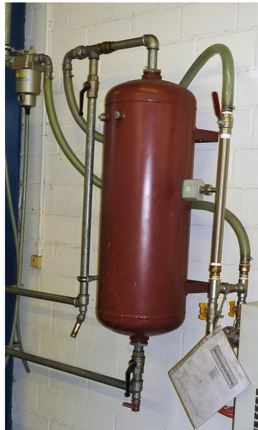
Foto 3: Druckluftspeicher für die Laserstanzmaschine mit zusätzlichem Kältetrockner (unten rechts) und provisorisch eingebauter Messstrecke mit Durchflussmessgerät CS Instrument VA520.
