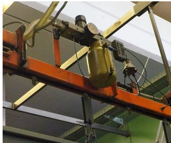
Foto 22: Pneumatisch betriebene automatische Schmiereinrichtung für den Kettenförderer.
