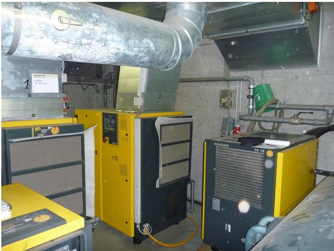
Foto 31: Kompressorraum mit den 3 Schraubenkompressoren (links der mit 7.5 kW, dann die beiden mit 18.5 kW), dem Kältetrockner (rechts) und dem Druckluftspeicher (rechts unten).
