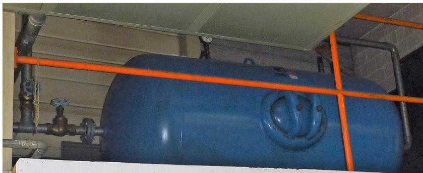
Foto 29: 2000 Liter Druckluftspeicher im Obergeschoss im Raum mit der Pulverbeschichtungsanlage.
