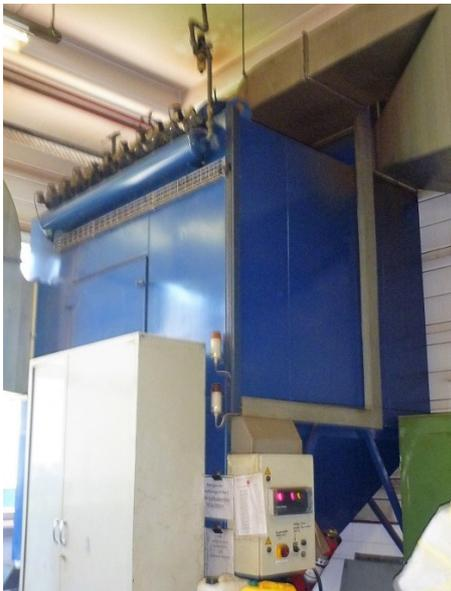
Foto 23: Absauganlage für Schweisserei mit pneumatischer Abreinigung.
