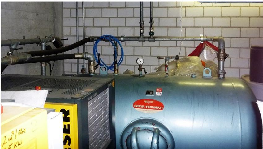
Foto 27: 2000 Liter Druckluftspeicher in der Druckluftzentrale im mittleren Geschoss mit den 3 Abgängen zu den Ringnetzen auf den 3 Gebäudeebenen.
