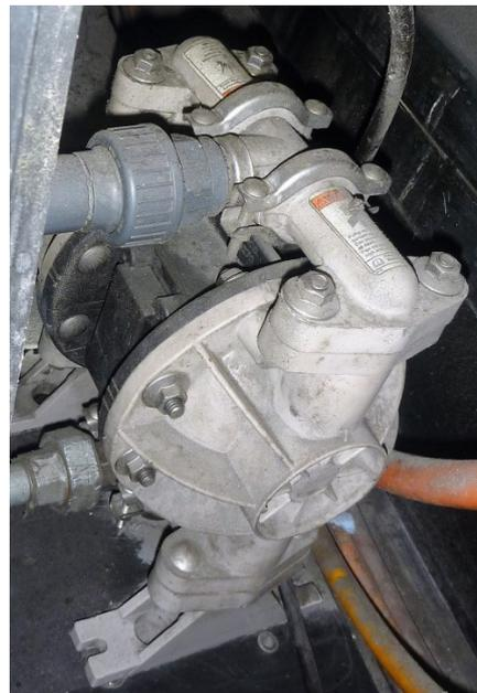
Foto 14: Pneumatische Membranpumpe.
