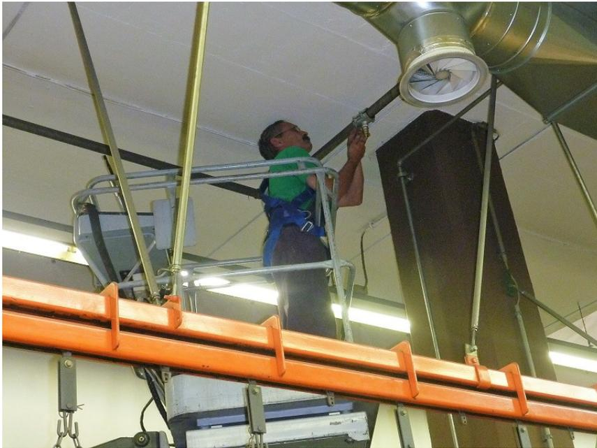
Foto 9: Einbau eines Luftabgangs für die temporäre Luftverbrauchsmessung der Pulverbeschichtungsanlage.
