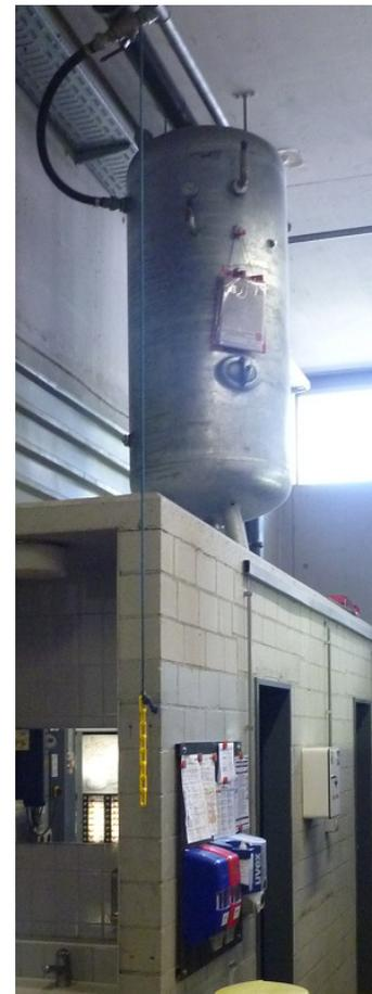
Foto 28: 1000 Liter Druckluftspeicher im Erdgeschoss.
