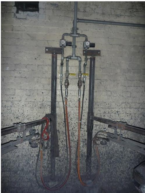
Foto 6: Verteilung von Erdgas und Druckluft für die beiden Pfannenvorwärmheizungen.
