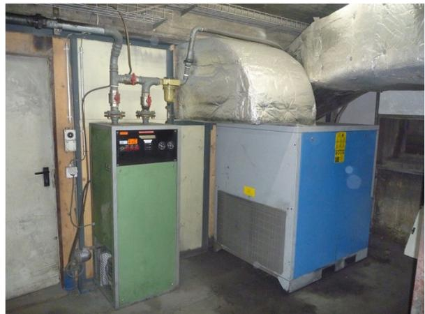
Foto 9: Kompressor 2, 37 kW mit Kältetrockner 2 (grün).
