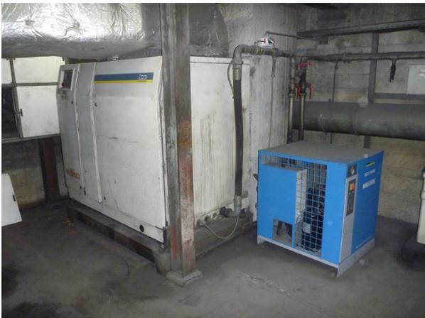
Foto 8: Kompressor 1, 45 kW und Kältetrockner 1 (blau).
