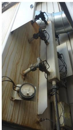
Foto 2: Ventile für Filterabreinigung
