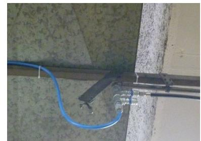
Foto 9: Leck am schwarzen Schlauchanschluss unter der Decke
