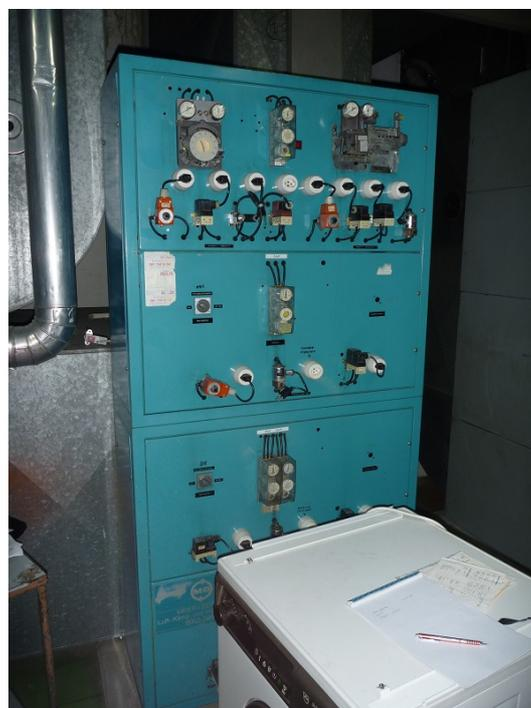
Foto 5: Hauptverteilung für die pneumatisch angetriebenen Lüftungsklappen. Hier wurde kein Leck gefunden.
