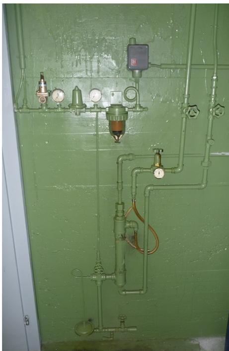
Foto 4: Alte, nicht mehr erforderliche und sehr undichte (unter dem Schauglas) Luftaufbereitung für die Lüftungsanlage.
