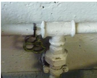
Foto 7: Leck an einer alten undichten Rohrverschraubung
