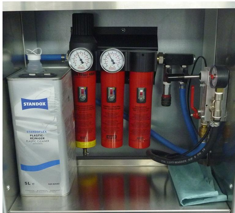
Foto 2: Die Druckluftaufbereitung für die Lackiererei mit einem Druck von 4 bar. Hier wurden keine Leckstellen gefunden.
