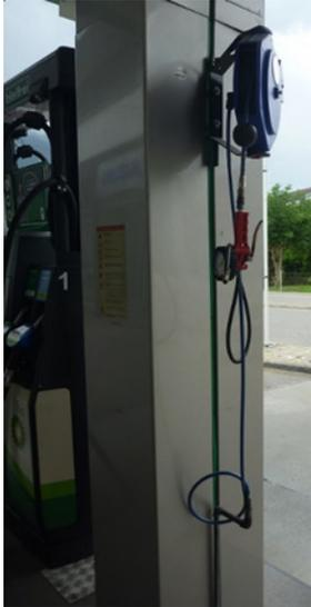
Foto 6: Druckluftanschluss an der Tankstelle
