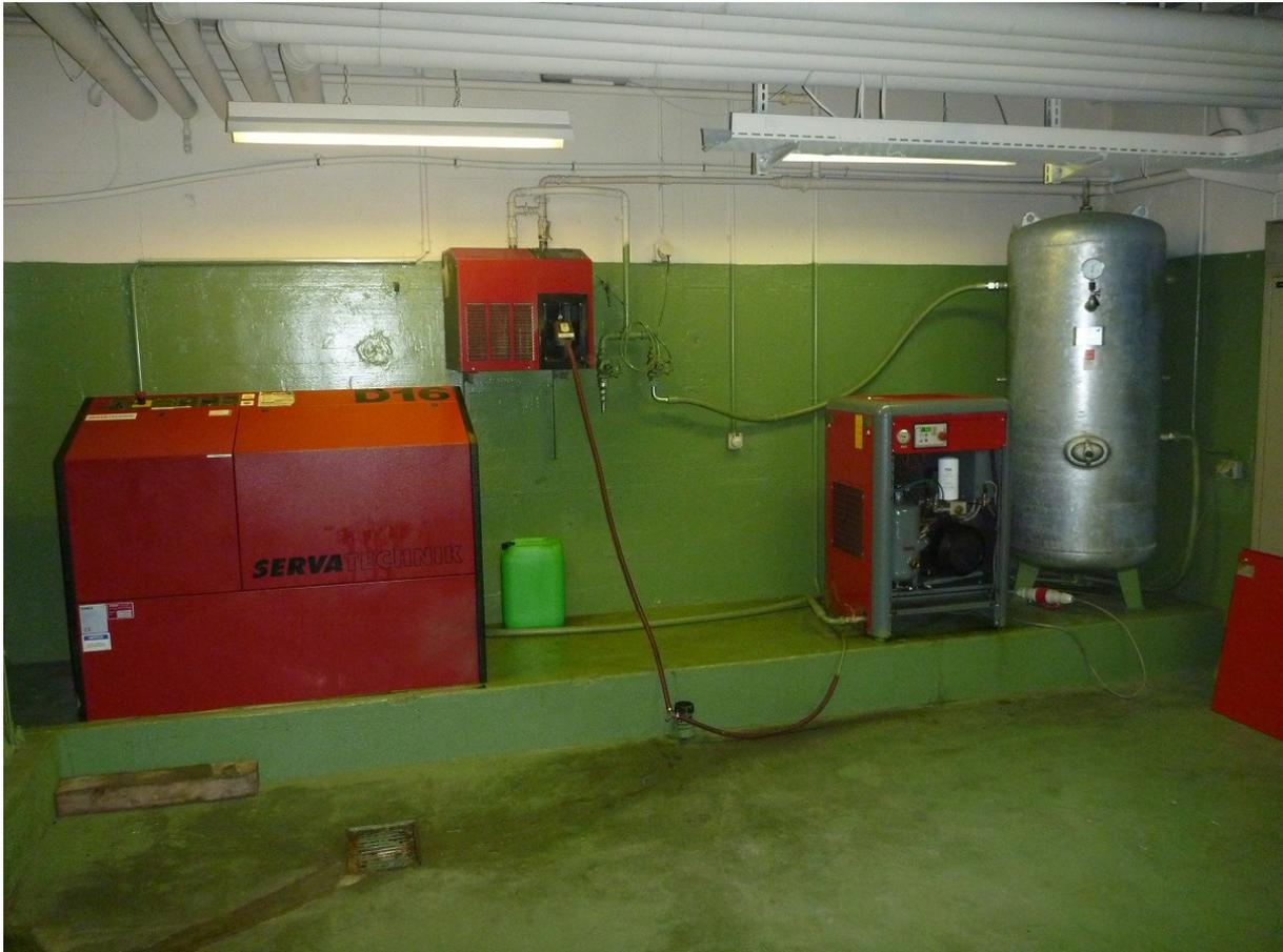
Foto 10. Kompressorraum. Links der alte 11 kW Schraubenkompressor, in der Mitte oben der Kältetrockner, rechts der neue 11 kW Schraubenkompressor und in der Ecke der 750 Liter Windkessel. Hier hat es keine Filter.
