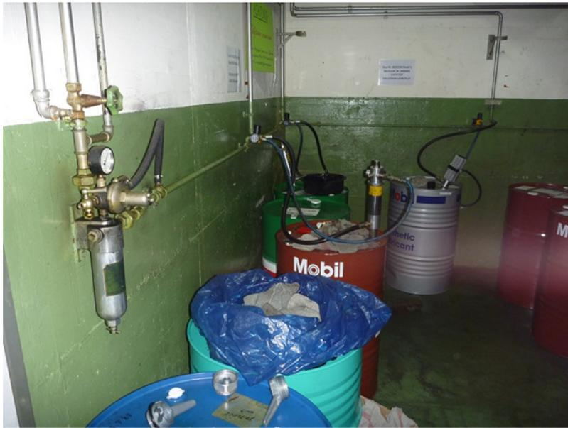
Foto 3: Leckes Druckreduzierventil für die 4 druckluftbetriebenen Ölpumpen.
