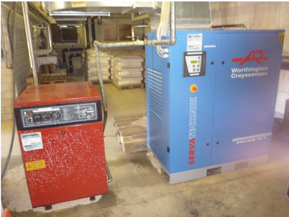
Foto 8: Kompressorraum. Links der alte 22 kW Schraubenkompressor (rot), rechts der neue drehzahlvariable 22 kW Schraubenkompressor (blau).
