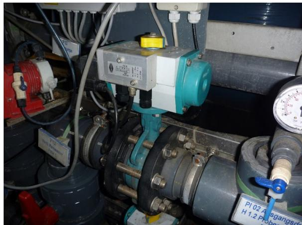
Foto 3: Schieber an der Sandfilteranlage. Aus dem Ventilblock strömt dauern viel Luft
