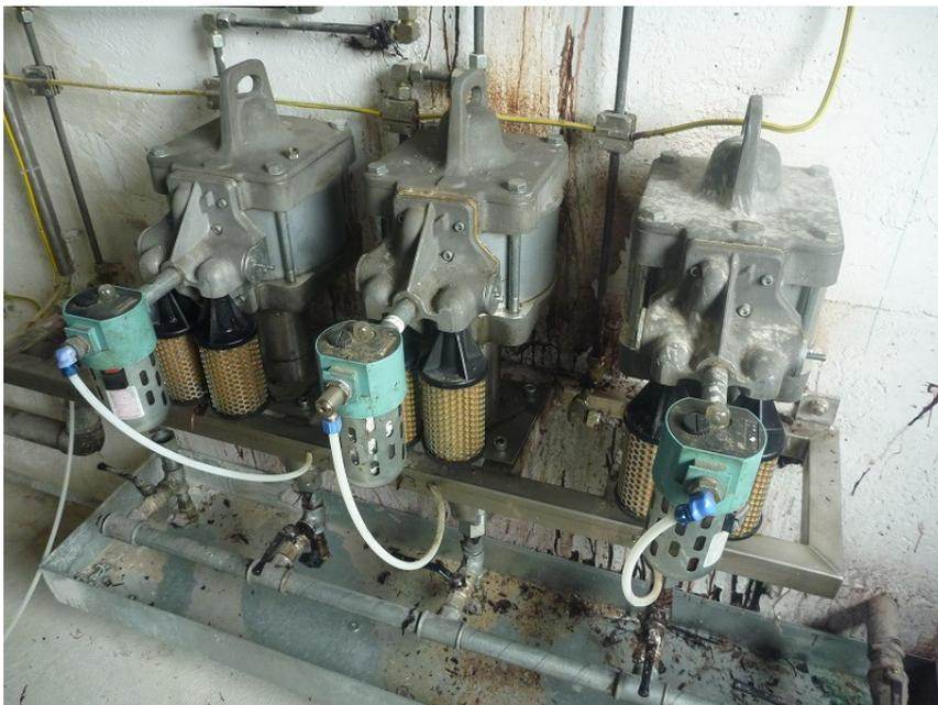
Foto 4: Pneumatisch betriebene Pumpen. Jede Pumpe läuft etwa für 1 Stunde pro Tag.
