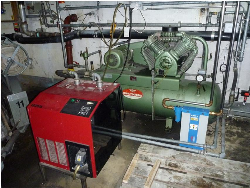
Foto 7: Kältetrockner (rot), Adsorptionstrockner (blau), Kolbenkompressor mit Speicher (grün) und an der Wand die Hauptverteilung mit den 9 Abgängen.
