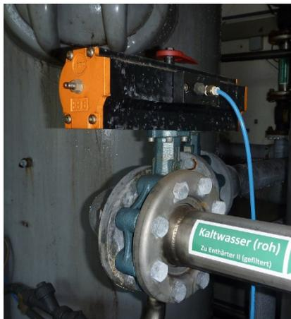
Foto 2: Schieber an der Anlage zur Wasserenthärtung. Aus der Unterseite des Antriebes entweicht viel Luft, wenn der Schieber offen ist.
