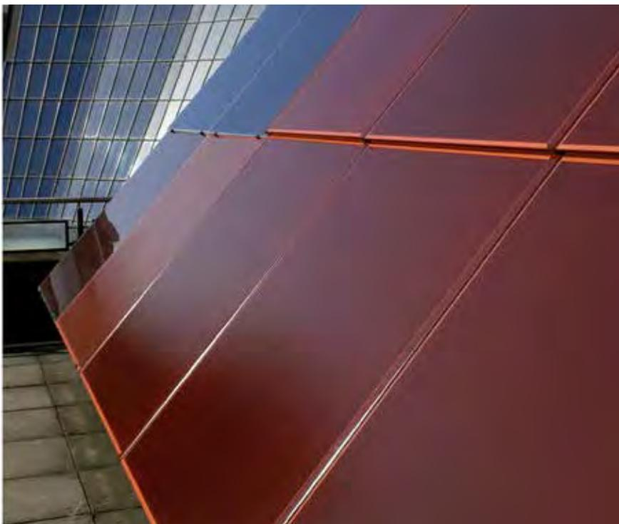
ser Effekt weitgehend behoben werden. Nebst den eigentlichen Demonstrationsmodulen in unterschiedlichen Farben wurden Konzepte für farbige Solarziegel mit Komposit-Strukturen entwickelt und getestet.
