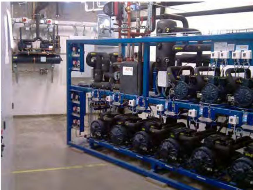
Figur 4: Transkritische CO<sub>2</sub>-Kälteanlage der Migros Bulli. Die Anlage versorgt mit 6 Verdichtern (-8 °C) die Kühlregale und 4 Verdichtern (-33 °C) die Tiefkühlräume. Die Temperatur für die Kühlregale konnte dank dem Einbau von 3 Ejektoren auf -2 °C angehoben werden.
