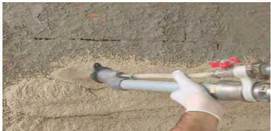
Figur 4: Applikation des Aerogel-Dämmputzes: Der Dämmputz wird im Spritzverfahren wie ein üblicher Putz in mehreren Schichten aufgetragen. Die Isolationswirkung des Dämmputzes entspricht derjenigen eines konventionellen Dämmmaterials bei gleicher Isolationsstärke, wobei beim Dämmputz Schichtdicken bis zu ca. 8 cm möglich sind. (Quelle: Homepage Fixit).
