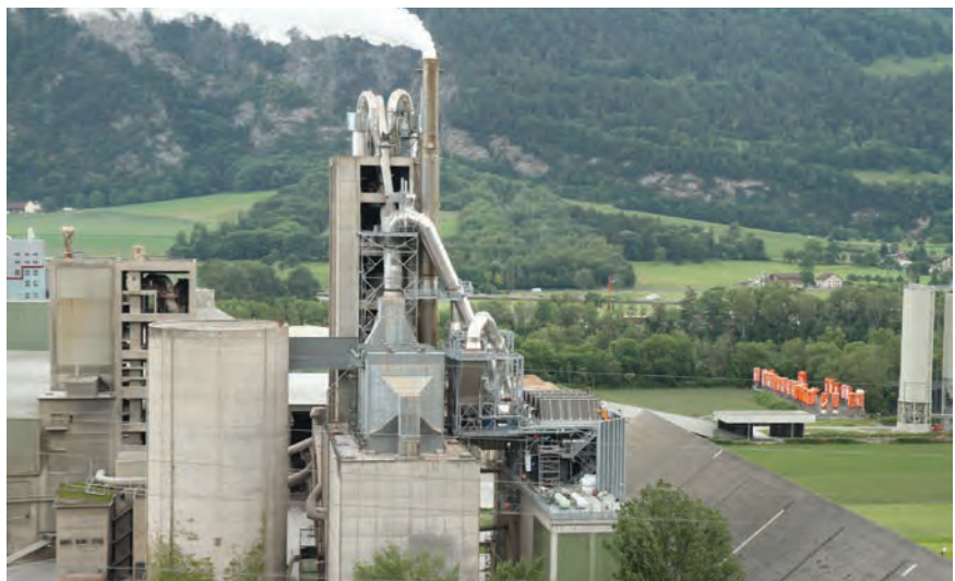
Figur 3: Holcim-Zementwerke mit der neuen 2 MWe-ORC-Abwärmeverstromungsanlage.
