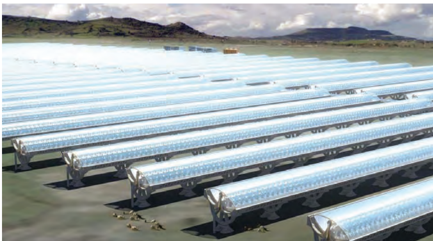
Figure 2 : Photo montage d'un parc CSP d'Airlight Energy (source : Airlight Energy).
