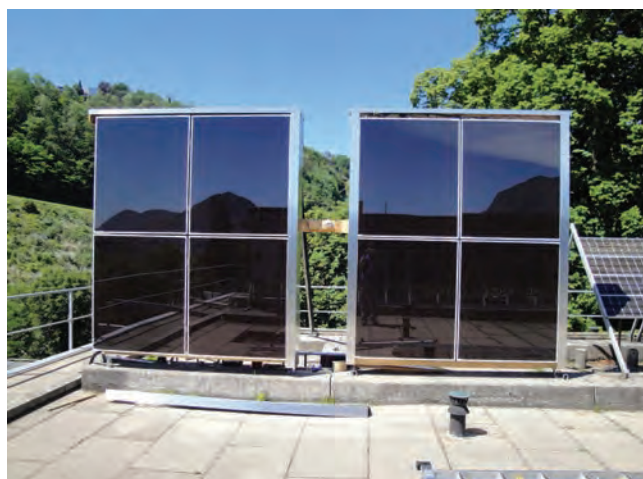
Figur 5: Feldtest von Prototypen aus dem Projekt PV Foamglas beim ISAAC SUPSI: Vorgehängte PV-Testfassade (links), geklebte PV-Testfassade (rechts) (Bildquelle: Basler & Hofmann).
