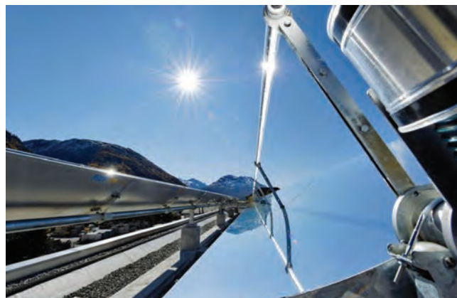
Figure 4 : Installation de Lalaria Engiadinaisa SA (LESA) à Bever dans le canton des Grisons (Source : ewz).
