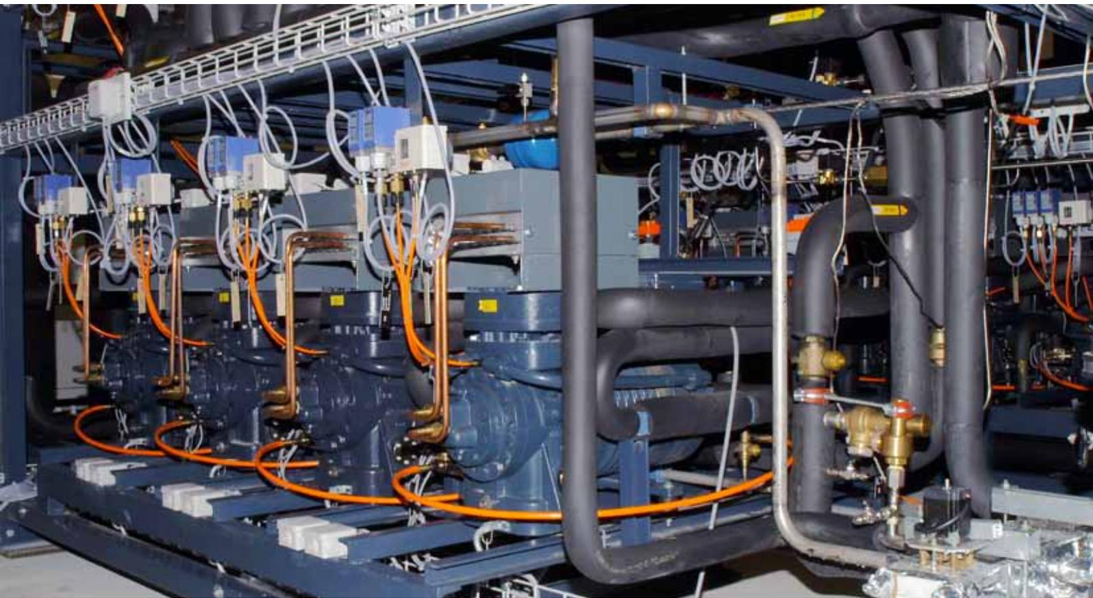
Expansionsmaschine zur Nutzung der Druckdifferenz zwischen Hoch- und Niederdruck in einer weltweit ersten, kommerziellen Pluskühlanlage mit CO<sub>2</sub> als Arbeitsmedium (R.Gerber, Frigo-Consulting AG, Gümligen)
