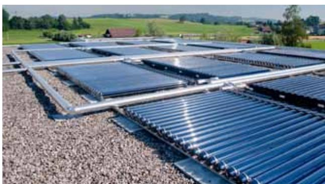
Figure 5 : capteurs solaires thermiques à tubes sous vide installé auprès de la fabrique de bougie Fischer AG à Root LU.
