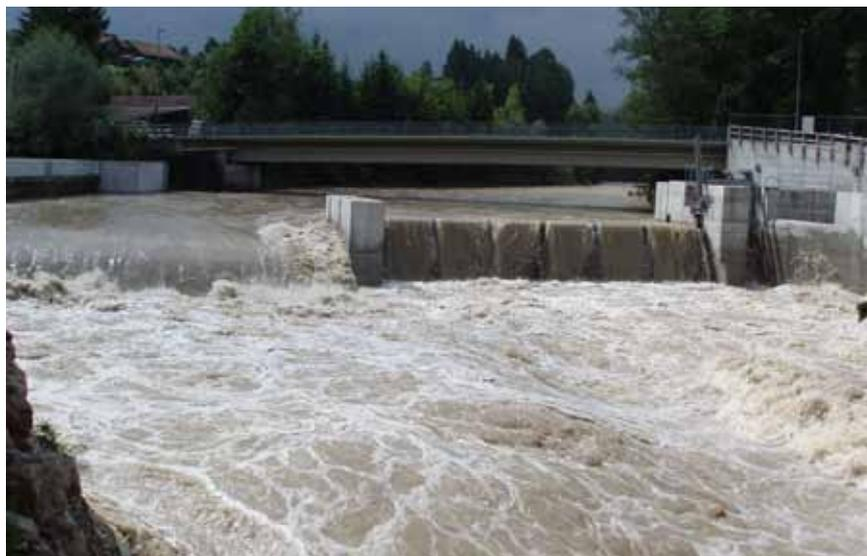
Figur 4: Hochwasser am Kraftwerk Mühlaus an der Thur. Das Wehrfeld ist einseitig geöffnet und die Strömungsrichtung verändert sich so, dass der Grossteil des Geschiebes vom Kraftwerkseinlauf (ganz rechts im Bild) ferngehalten wird.
