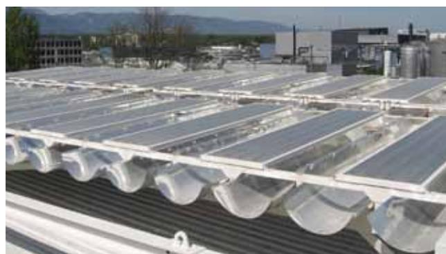
Figure 6 : capteurs solaires thermiques à ultra vide installé auprès de Colas Suisse à Genève.
