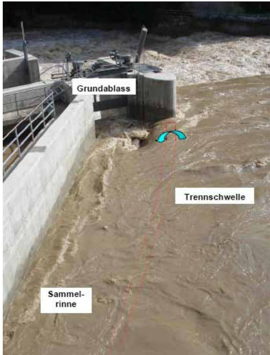
Figur 6: Bei Hochwasser wird das ankommenden Geschiebes in der Sammelrinne im Einlauf gefasst und direkt über den Grundablass weiter abgeführt, bevor es in den Einlauf gelangen kann.
