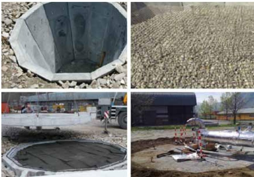
Figure 4 : construction du système de stockage d'énergie thermique à Biasca : lit de galets en place (en haut à droite), montage du couvercle (en bas à gauche), système prêt pour les tests de charge-décharge (en bas à droite).
