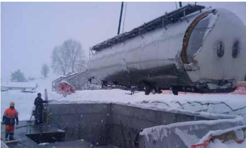
Figur 3: Milchtransporter-Auflieger-Tank als Wärme-Speicher für ein EFH [21].
