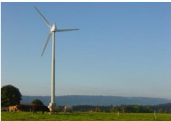
**Figur 3:** Eine der untersuchten Anlagen ist die 6 kW-Aventa AV7 am Standort in Tramelan.
