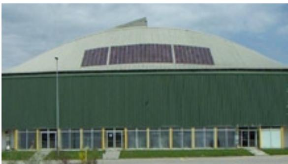
**Figur 10:** 2-kWp-Flexcell Experimentaldach (Bildquelle: VHF Technologies)
