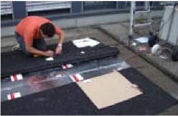
Figur 10: Einbau der VIP Testfelder
