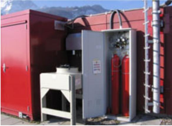
**Figur 24:** Aussen Ansicht der USV-Anlage für Mobilfunkantennen mit Luftkühler und  $H_2$ -Druckflaschen direkt neben der Antenne [26].
