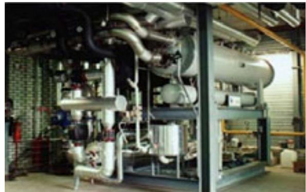
Figur 6: Absorptionskälteanlage (Quelle FH Burgdorf).
