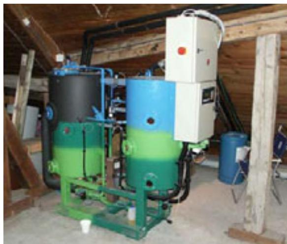
**Figur 14:** Absorptionsmaschine Weingut Schloss Salenegg (Quelle: EAW WEGARCAL 15).
