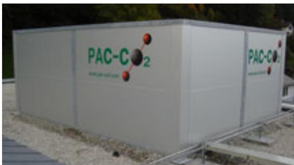
**Figur 4:** CO<sub>2</sub>-Wärmepumpe zur Trinkwasserbereitung auf dem Dach des Spitals von Le Locle.
