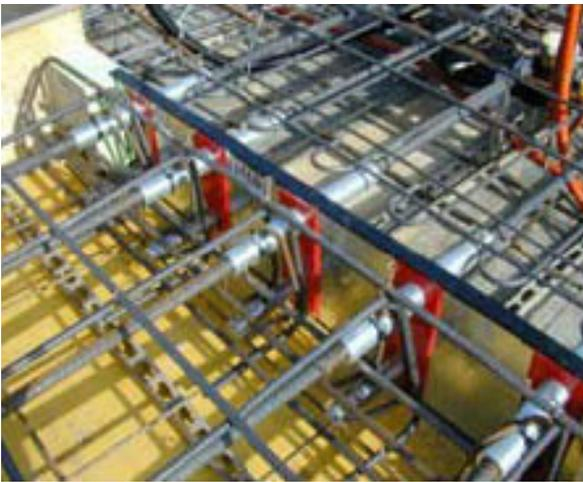
**Figur 10:** Thermotragelemente (TTE) aus hochfestem Faserverbundstoff und integrierten Vakuumisoliationspaneelen.
