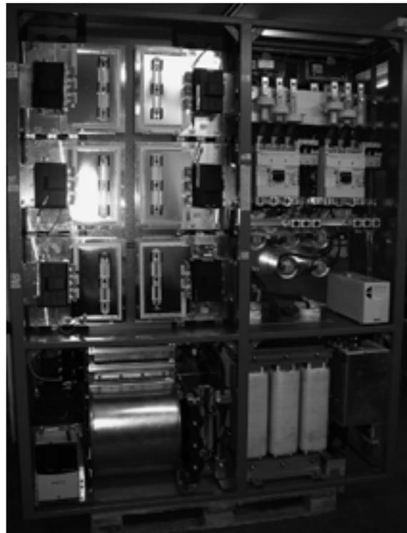
**Figur 3:** Prototyp des 1'200 kW Umrichters kurz vor der Fertigstellung (Quelle: Technocon AG)
