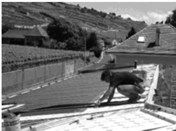
**Figur 9:** Montage der PV Dachintegration mit amorphen Tripelzellen «Freestyle®» in Lutry (Bildquelle: Solstis)
