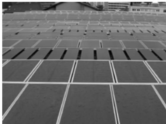
**Figur 10:** 18 Testanlagen mit Dünnschichtzellen im direkten Vergleich, Migros, Zürich (Bildquelle: NET AG)
