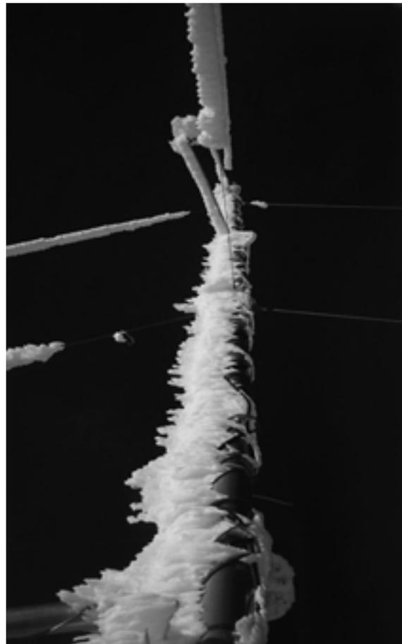
**Figuren 4 und 5** Bei tiefen Temperaturen lagern sich an Messmasten und Abspannungskabeln Eis und Schnee ab, was zu grossen Lasten und grösserer Angriffsflächen bei Böen führt. Bilder von der Messkampagne auf dem Gottardpass (2'100m.ü.M.) durch NEK Umwelttechnik.
