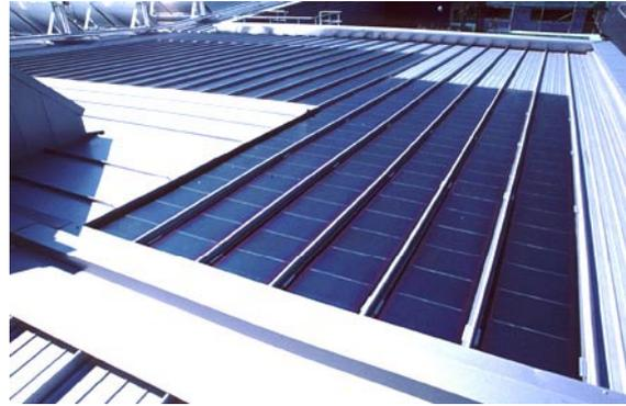
**Figur 9:** Thermisch isoliertes Photovoltaik Metallfalzdach (Bildquelle: NET AG) mit amorphen Zellen
