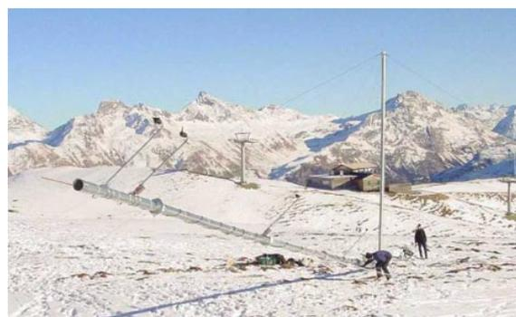
**Figur 4:** Errichtung eines 50 m Messmasten am zukünftigen Standort einer Windkraftanlage in St. Moritz. (Foto: ABB Energie Services Schweiz)
