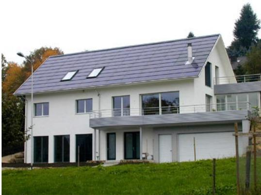
**Figur 6:** Dachintegration mit SOLRIF, Hedingen, (Bildquelle: NET AG)
