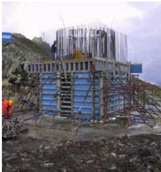
**Figur 6:** Schalung des Mastunterteils der 850-kW-Anlage Gütsch (Foto: Weisskopf Partners GmbH)
