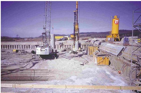
**Figur 4:** Baustelle Dock Midfield: Einbringen der Energiepfähle
