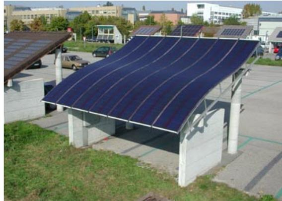
Figur 4: Photovoltaikdach Freestyle (Demosite), (Bildquelle: LESO / EPFL)
