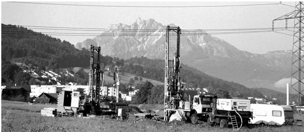
*Deux forages pilotes de 160 m de profondeur ont été réalisés à Lucerne sur le site de stockage saisonnier de chaleur du futur complexe de la SUVA et une nouvelle méthode de tests de réponse a permis de déterminer la qualité thermique des sondes in situ pour dimensionner au mieux le stock et les longueurs de sonde nécessaires.*
