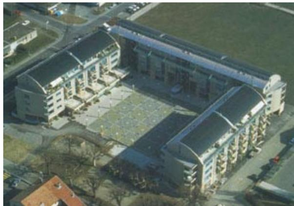
*La cité solaire de Plan-les-Ouates et sa toiture d'absorbeurs.*
