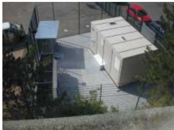
Abb. 3: PC 25C Brennstoffzelle als Kompaktanlage für Aussenauftellung in Birsfelden
