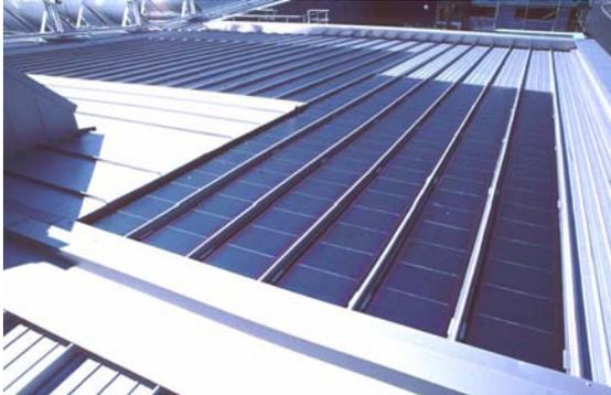
Bild 6: PV Metallfalzdach thermisch isoliert
