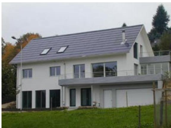
Bild 4: Dachintegration mit SOLRIF
