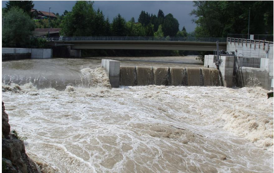
Figur 4: Hochwasser am Kraftwerk Mühlau an der Thur. Das Wehrfeld ist einseitig geöffnet und die Strömungsrichtung verändert sich so, dass der Grossteil des Geschiebes vom Kraftwerkseinlauf (ganz rechts im Bild) ferngehalten wird.
