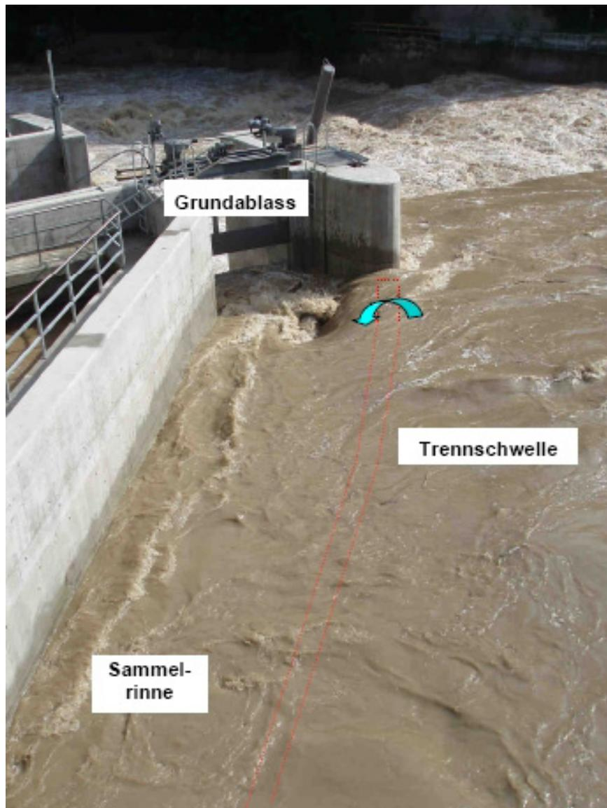
Figur 6: Bei Hochwasser wird das ankommenden Geschiebes in der Sammelrinne im Einlauf gefasst und direkt über den Grundablass weiter abgeführt, bevor es in den Einlauf gelangen kann.
