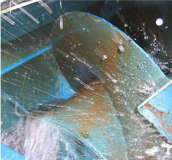
**Abbildung 4:** Wasserkraftschnecke in Derendingen, eine in der Schweiz erstmals eingesetzte Technologie
