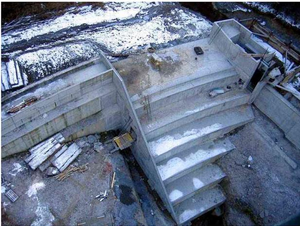
**Abbildung 5:** Sanierte Staumauer des Kleinwasserkraftwerks Buchholz. In der Mitte das Treppengerinne der neuen zentralen Hochwasserentlastung.
