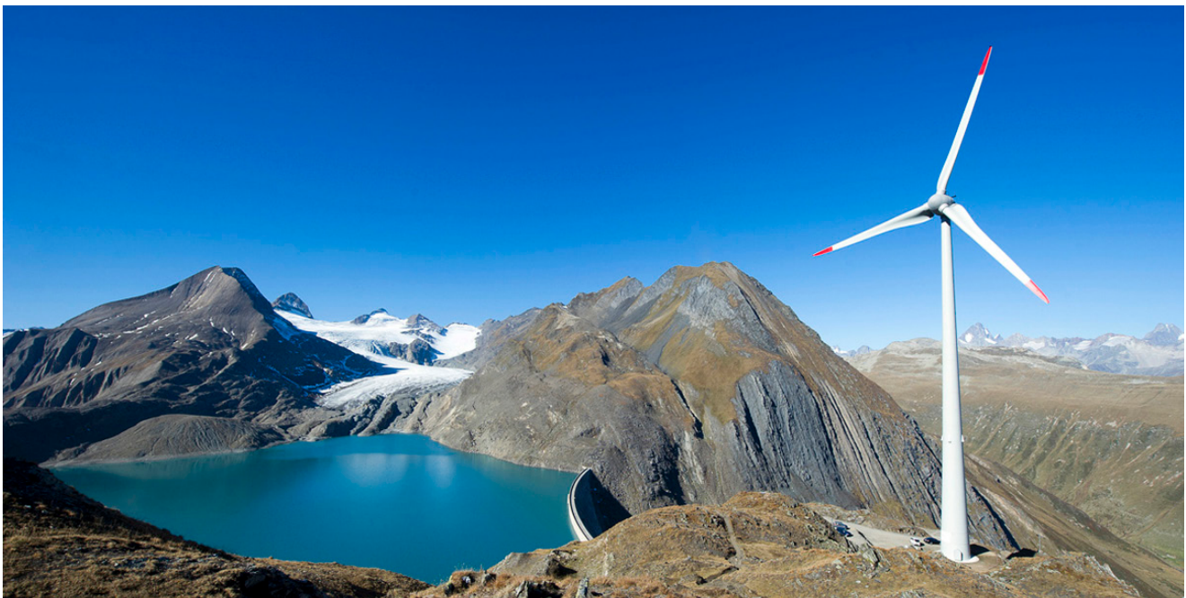
Figur 1: 2011 wurde die höchst gelegene Windkraftanlage (2'465 m.ü.M.) beim Griesssee am Nufenenpass durch die Fa. Swiss Winds errichtet (Quelle: Swiss Winds / Scheuerle).
