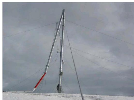
**Figur 6:** Der aufgrund von hohen Eislasten und hohen Windgeschwindigkeiten geknickter Messmast auf dem Schwyberg, Kanton FR.
