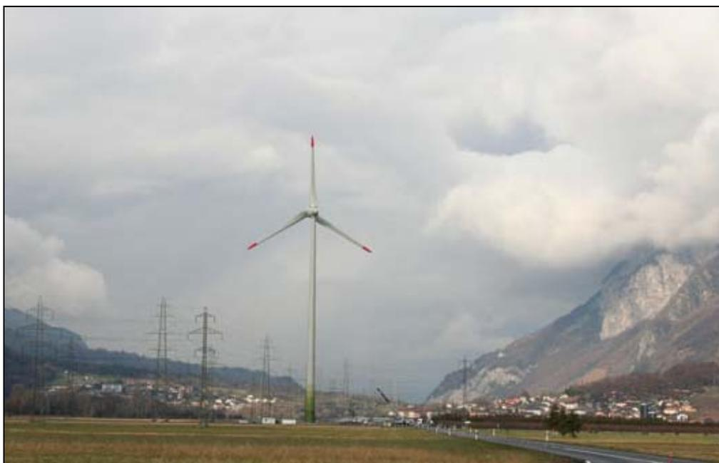
**Figur 9:** 2 MW-Anlage Enercon E70 in Collonges, Jahresproduktion 2006 über 4 GWh.
