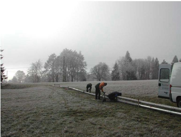
**Figur 4:** Installation des Windmessmasten am Standort *Peu Girard, Les Breuleux (JU)*
