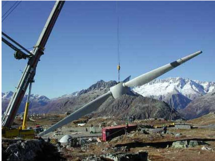
**Figur 4:** Montage des Rotors der neuen Enercon E-40-Anlage auf dem Gütsch.
