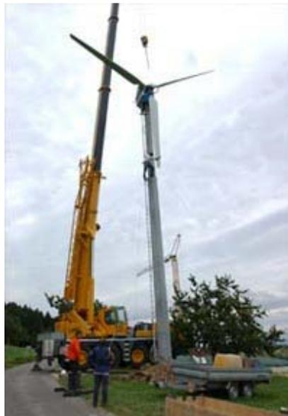
**Figur 5:** Montage einer 7 kW-Windkraftanlage bei Rüttenen SO
