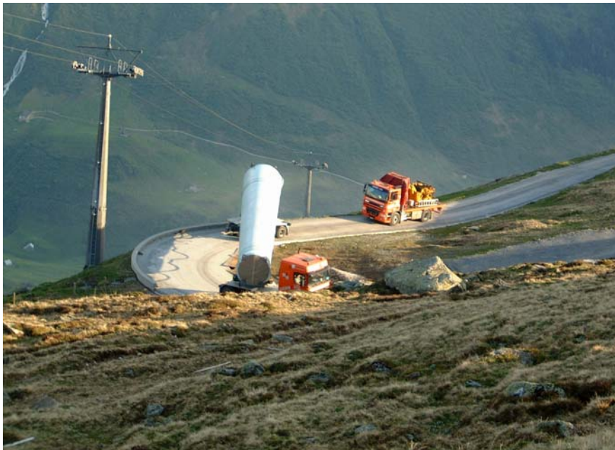
Figur 7 Transport des Mastunterteils auf der Bergstrasse zum Gütsch (Foto : EW Ursern)
