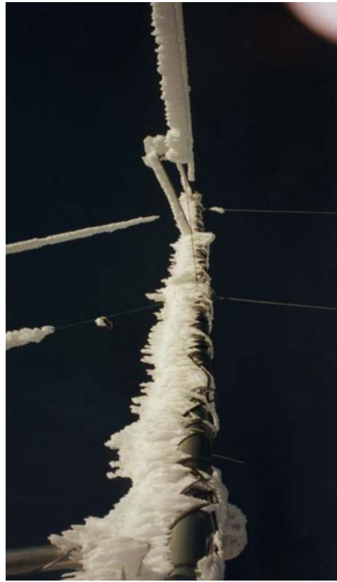
Figuren 4 und 5 Bei tiefen Temperaturen lagern sich an Messmasten und Abspannungskabeln Eis und Schnee ab, was zu grossen Lasten und grösserer Angriffsflächen bei Böen führt. Bilder von der Messkampagne auf dem Gottardpass (2'100m.ü.M.) durch NEK Umwelttechnik.
