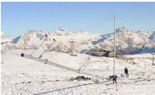
**Fig. 5** Errichtung eines 50 m Messmasten am zukünftigen Standort einer Windkraftanlage in St. Moritz. (Foto: ABB Energie Services Schweiz)
