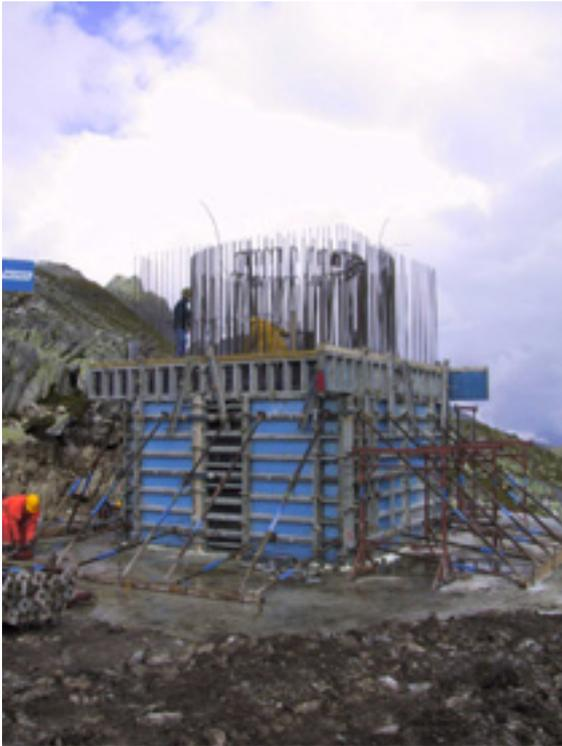
**Fig. 7** Schalung des Mastunterteils der 850-kW-Anlage auf dem Gütsch (Foto : Weisskopf Partners GmbH)
