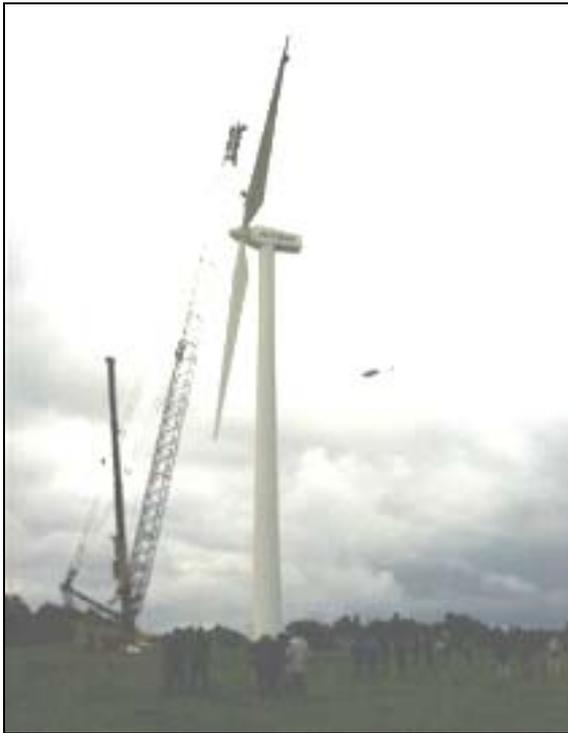
Fig. 2: Installation einer 850-kW-Anlage auf dem Mt-Crosin durch Juvent SA (Foto: ENCO GmbH)
