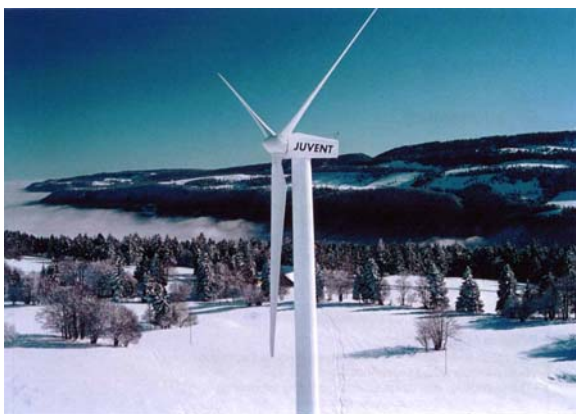
Windpark Juvent SA auf dem Mont Crosin: Erweiterung um zwei Windkraftanlagen mit einer Leistung von je 850 kW ist beschlossen Foto: Juvent SA
