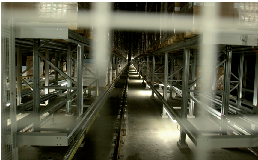
Figur 3: Blick in das Tiefkühlager der Migros in Neuendorf. Die Temperatur in dem vollautomatischen Hochregallager beträgt standardmässig -26.5^{\circ}\text{C} . (Quelle: Benedikt Vogel)
