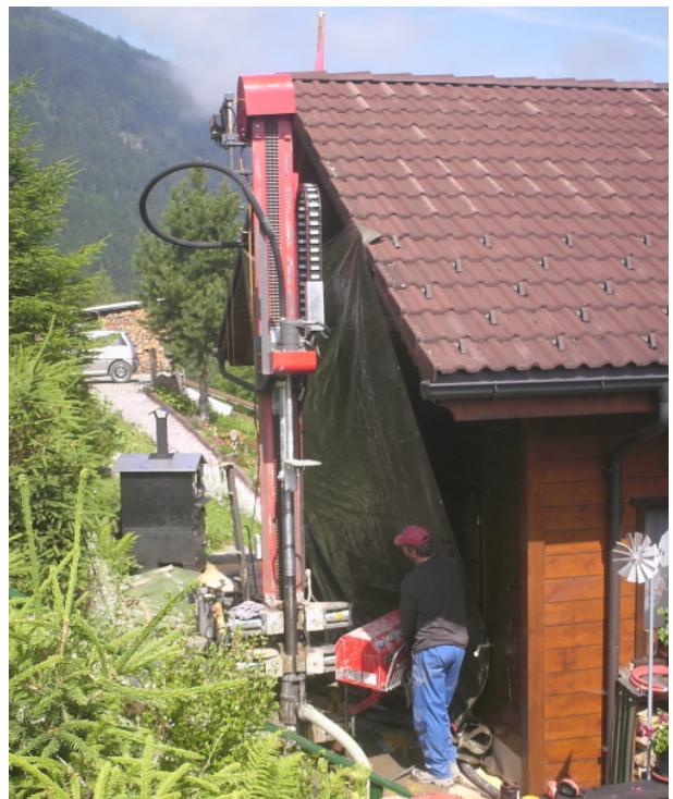
Figur 3: Das Bohrgerät Terradrill kann bei engen Platzverhältnissen eingesetzt werden. (Quelle: Terra AG)
