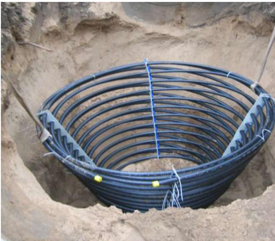
**Figur 1:** Erdwärmekorb vor der Verfüllung (oberer Durchmesser ca. 150 cm).
