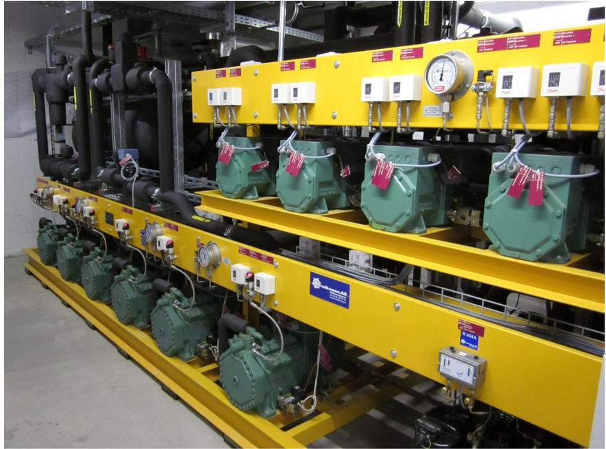
Figur 3: Transkritische CO<sub>2</sub>-Kälteanlage der Migros Ebikon. Anlage mit 10 Verdichtern, wovon 5 für die Pluskühlung (170 kW), 4 für die Minuskühlung (40 kW) und 1 als Parallelverdichter eingesetzt werden [10].
