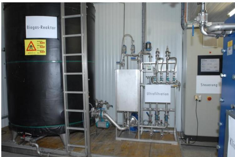
Innenansicht der Membran-Bioreaktor-Versuchsanlage mit den wichtigsten Komponenten (Ingenieurbüro Hersener)
