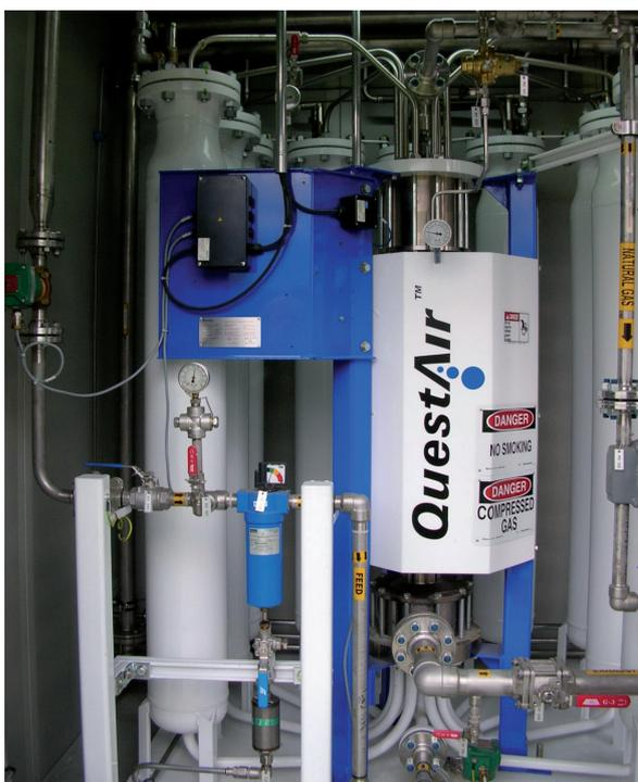
Figur 10: Gasaufbereitungsstation (PSA) zur Einspeisung ins Erdgasnetz. (Rhy Biogas AG; Widnau)
