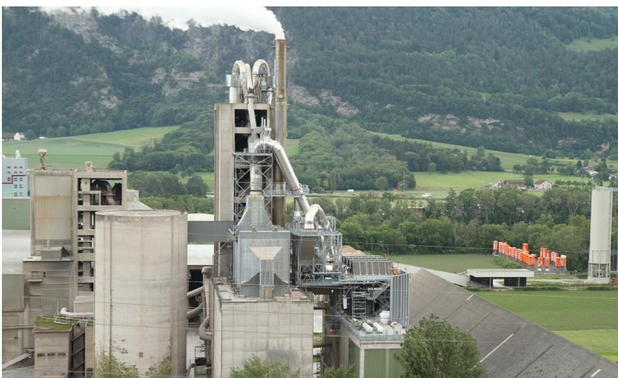
Figur 3: Holcim-Zementwerke mit der neuen 2 MWe-ORC-Abwärmeverstromungsanlage.
