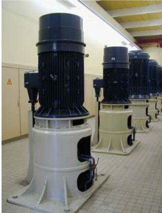
**Figur 5:** Netzwasserpumpen bei Novartis (Quelle: Semafor AG, Basel)
