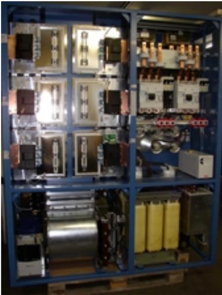
**Figur 3:** Prototyp des 1'200 kW Umrichters kurz vor der Fertigstellung (Quelle: Technocon AG)
