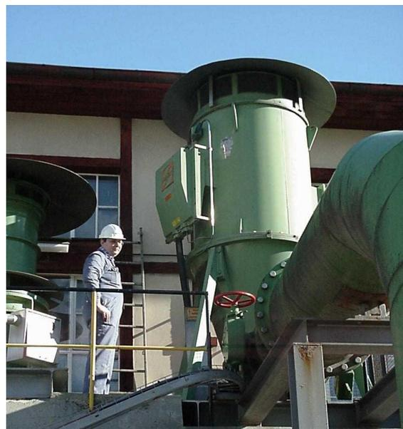
**Figur 7:** HS-Netzwasserpumpe bei der Lonza (Quelle: Lonza AG, Visp)
