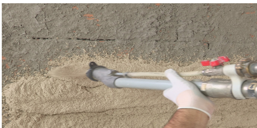
Figur 4: Applikation des Aerogel-Dämmputzes: Der Dämmputz wird im Spritzverfahren wie ein üblicher Putz in mehreren Schichten aufgetragen. Die Isolationswirkung des Dämmputzes entspricht derjenigen eines konventionellen Dämmmaterials bei gleicher Isolationsstärke, wobei beim Dämmputz Schichtdicken bis zu ca. 8 cm möglich sind. (Quelle: Hompage Fixit).
