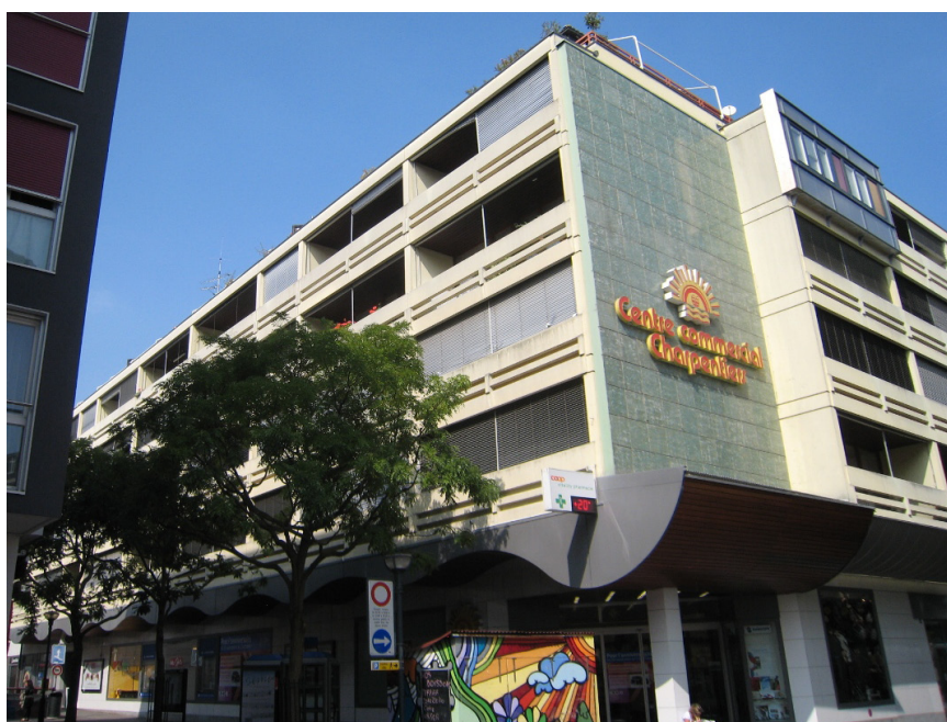
Figur 5: Fassade des Mehrfamilienhauses in Morges vor der Sanierung (Quelle: HEIG-VD LESBAT).
