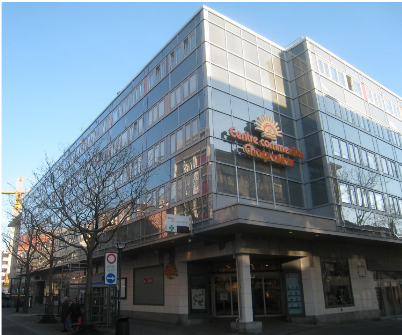
Figur 6: Fassade des Mehrfamilienhauses in Morges nach der Sanierung (Quelle: HEIG-VD LESBAT).
