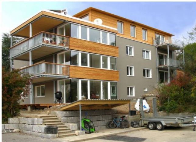
Figur 3: Mehrfamilienhaus-Erneuerung Zürich-Höngg [58]. Das Gebäude wurde nicht nur mit vorgefertigten Elementen gedämmt; gleichzeitig wurden auch die Wohnräume vergrössert, grosszügige Balkone vorgesetzt und eine neue Attikawohnung realisiert. Aus dem «Block» der 1950er Jahre ist ein modernes Mehrfamilienhaus entstanden (Projekt und Bildnachweis Arch. Beat Kämpfen, Zürich)
