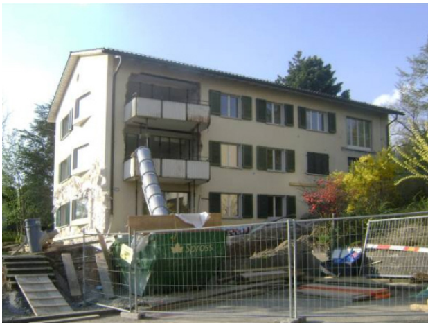
Figur 3: Mehrfamilienhaus-Erneuerung Zürich-Höngg [58]. Das Gebäude wurde nicht nur mit vorgefertigten Elementen gedämmt; gleichzeitig wurden auch die Wohnräume vergrössert, grosszügige Balkone vorgesetzt und eine neue Attikawohnung realisiert. Aus dem «Block» der 1950er Jahre ist ein modernes Mehrfamilienhaus entstanden (Projekt und Bildnachweis Arch. Beat Kämpfen, Zürich)
