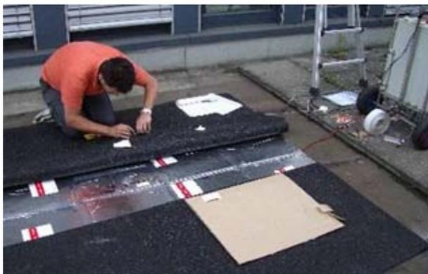
Figur 10: Einbau der VIP Testfelder
