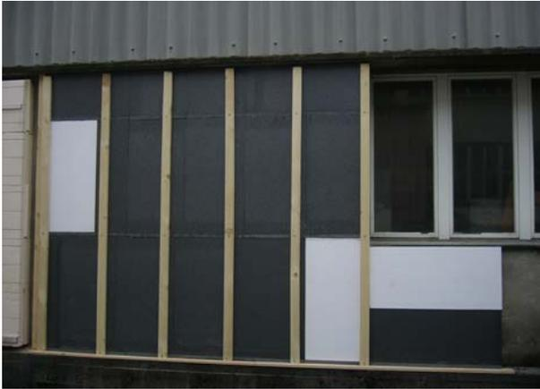
**Figur 7:** Ansicht der Testmontage des Distanzschrauben-Systems, vor der Montage der Aussenschale (FHNW).
